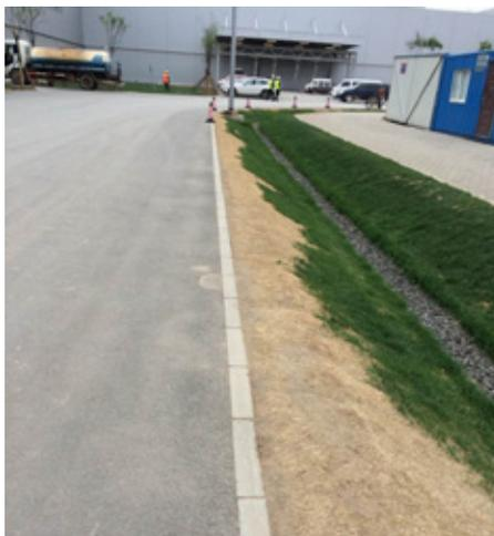
图9 中德（沈阳）高端装备制造产业园——华晨宝马铁西厂区渗水沟
