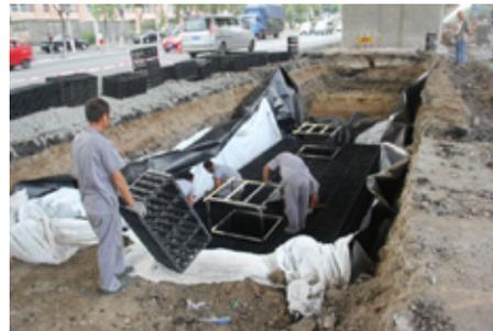
图10 迎宾路高架桥雨水蓄水池现场施工图
